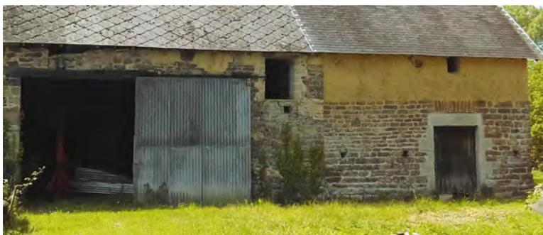
On observe parfois des remaniement du bâti, ne respectant pas toujours les données architecturales d'origine (création de nouvelles ouvertures notamment au nord, recouvrement des façades ou seulement des joints par des enduits cimentés, habillage de briques ou de béton autour des ouvertures, recouvrement des façades par des bardages).
