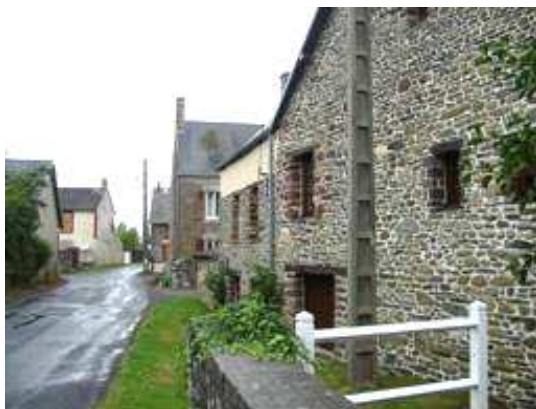
Village rue du Pont-Guyot. Implantation traditionnelle des maisons
