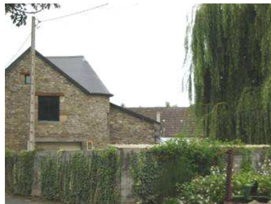
De nombreuses maisons anciennes ont été restaurées
